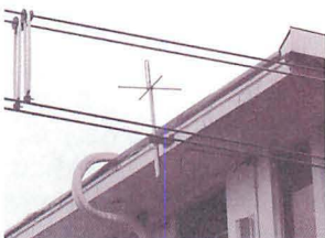
▲京王線桜上水駅構内に建っている保線などの構内作業用無線のアンテナのようです。
