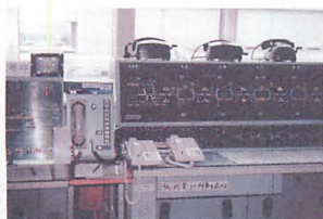
▲CTC装置で大半の私鉄では列車の位置と信号の現示を操作卓で逐一監視できます。
