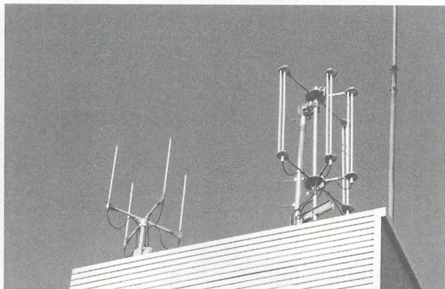
▲従来型500mW（左）と高感度指向性アンテナ（右）のヘア設置。この誌面でも何度も書いているが、高感度指向性アンテナも出力は500mW。
