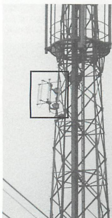
▲KDDI系携帯電話鉄塔に設置された高感度指向性アンテナ（□内）。3km先まで電波を飛ばせるこのアンテナの導入で高速道路、山間部、リゾート地域のエリア構築が飛躍的に向上した。DDIポケットは9月までに全国規模でエリアを大幅に拡大する予定。
