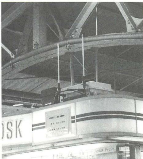
▲首都圏JR駅構内のキオスク店舗に設置された独立型アンテナ。ビルの谷間にあるJR駅内でも通話安定性が向上した。
