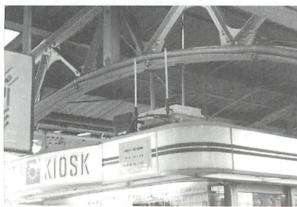
▲JR駅ホームのキヨスク店舗に設置された20mW独立型基地局。改札口付近の店舗に設置されている場合もある。キヨスクあらばアンテナあり!!
