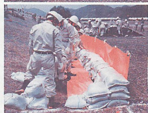
▲改良積み土のう工の作業。 長さ約10mのシートを鉄棒でL字型にし、内側に土のうを積み。目的は越水防止。
