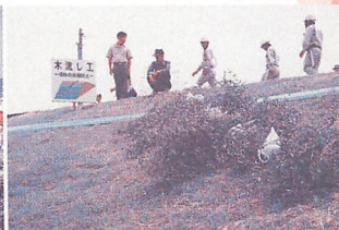
▲木流し工の作業。 3本の竹を束ねた上に土のうを付け堤防に固定、目的は洗掘防止（崩壊防止）。
