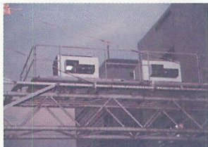
▲第一世代。異様な一体型ボディが特徴。カメラの手前には、カメラのシャッター相当の車両センサーが設置されている。
