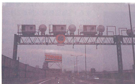
▲円錐型のレーダー受信機が設置されているタイプだが、速度取り締まりには使われていない模様（大阪型）。
