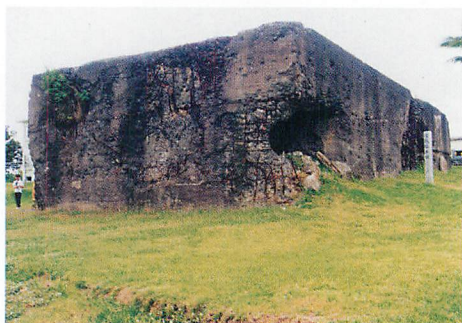
▲日本軍のトーチカ跡。側に陸戦隊本部跡と書かれた碑が建てられている。厚さ数10センチのコンクリートで覆われており、トーチカの周囲は激しい弾痕が残されている。このトーチカは現在では資料館として使用されている。
