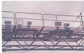
▲第三世代。97年後半に登場した最新タイプはスマートな2箇コンパクトなデザインに進化。赤外線無ストロボ（左）と、CCDカメラ（AVI兼用）のシンプルな構成になっている。
