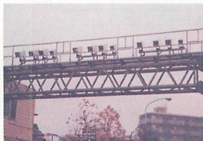
▲第二世代。95年のオウム事件の後、大激増したのがこのタイプ。左から赤外線ストロボ、CCDカメラ2基（解像度の関係で、2箇1セットで1車線を撮影）、AVI（車両認識センサー）という4箇構成だ。松下通工製。
