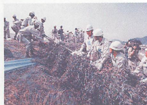
▲木流し工の作業。 3本の竹を束ねた上に土のうを付け堤防に固定、目的は洗掘防止（崩壊防止）。
