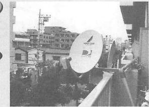
▲ポールさえ確保できれば、パラボラアンテナの設置は簡単。DXアンテナのパラボラアンテナはドライバー1本で設置できてしまった。
