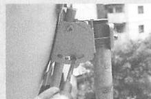
▲アンテナを設置したら、まず仰角をセットする。仰角は自盛りに合わせるだけ（偏差角・仰角・向きは地域によって異なるので、説明書で確認すること）。
