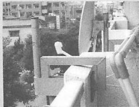
▲パラボラアンテナを設置するためには、ポール（支柱）が必要。そこで、取り付け場所に合った取り付け金具が必要。各種金具が売っているので、適切なものを購入すること。
