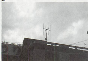
▲NTTパーソナルの新型500mWアンテナ。那覇市内では多く見られた。
