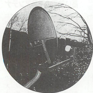
▲写真-1 パラボラの後面上半分に何気なくついている地上波用アンテナ。
