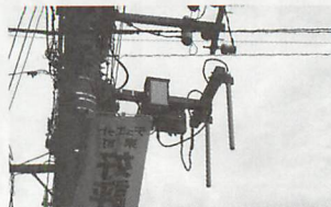
▲これも太いアンテナのアステルの基地局。型が古いのか、他に理由があるのかはわからない。
