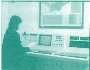
▲800MHz帯の地域防災無線機と防災同報無線の操作卓。同報無線はリアルタイムのアナウンスは少ない。
