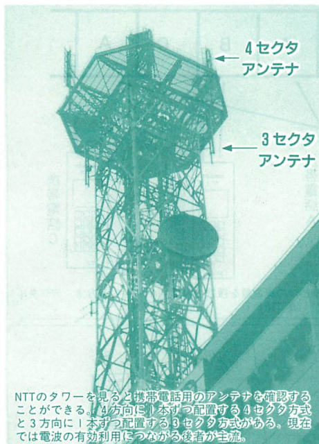
携帯電話の中継機は、指向性のアンテナを複数用いて360°をカバーする。アンテナを4本用いる4セクタ方式、アンテナを3本用いる3セクタ方式がある(図)。ひとつの中継機が受け持つエリアは六角形(セルラ方式)だ。
