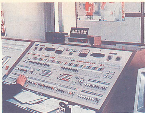
▲こちらは「消防指令台」。救急指令台とお揃いのNEC製です。ちょうどこのとき通信員の方が出動中の消防隊と連絡をとっていました。左隣には車両表示設定台が見えます。
